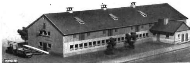
Bild 1. Gesamtansicht des Rinderstalles mit Milchhausanbau
