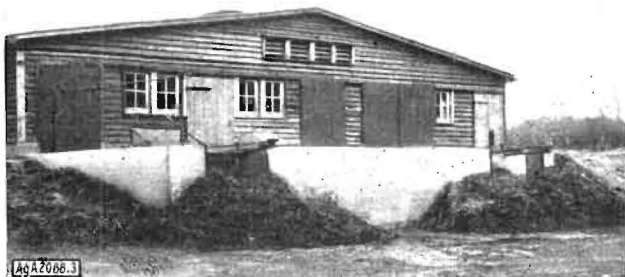
Bild 3. Der aus dem Stall herausgeschobene Mist fällt auf die vertieft angelegte Düngplatte oder einen untergestellten Stalldungstreuer
