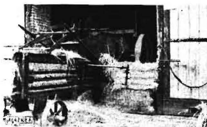
Bild 8. Schutz des Hauptantriebsrades einer Krummstrohpresse durch Vorstellen von zwei Preßstrohhallen (Kreis Bernau)
