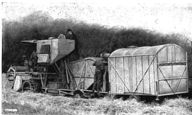
Bild 2. „Durch das tiefe Einsinken des Spreuwagens ist das Lenken fast unmöglich.“ (S. a. unter 6: Lenkung)
