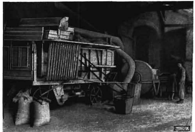
Bild 1. Komplette Häckseldruschanlage mit „Dechentreiter“-Dreschmaschine, Gebläsehäcksler GSH 380 und Gebläse ME 35
