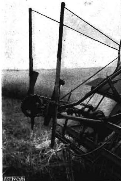
Bild 2. Ein Garbentrenner dieser Art (am Fella-Binder) müßte sich auch an unsere Mähbinder montieren lassen
