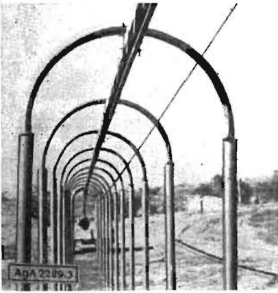
Bild 3. Traggerüstkonstruktion aus Stahlrohren im Zweiginstitut Chortiza
