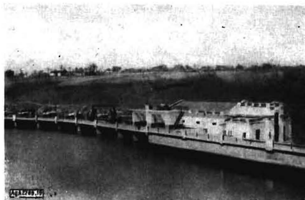
Bild 19. Wasserkraftwerk Steblewskaja am Ros. Staumauer und Maschinenhaus
