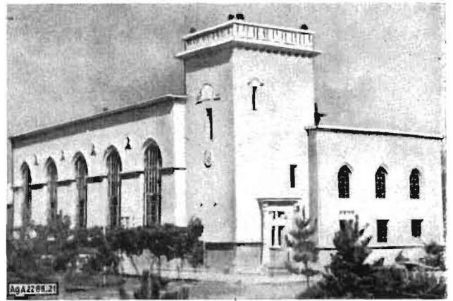
Bild 21. Wasserkraftwerk Tiripoin in Grusinien, Maschinenhaus
