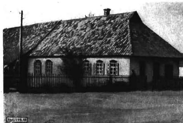
Bild 18. Schindelgedecktes Bauernhaus mit drei Stuben, Küche und Wirtschaftsräumen auf dem Kolchos Belenkaja
