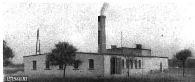
Bild 1. Tabaktrocknungsanlage der LPG „Walter Ulbricht“ in Jerschel, Krs. Gardelegen
