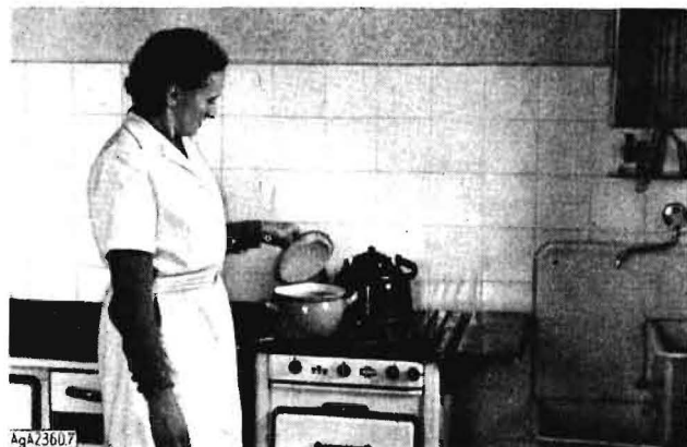
Bild 7. Für Biogas umgebauter Stadtgasherde in einem Landarbeiterwohnhaus
