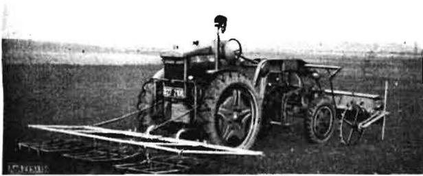
Bild 18. „Ruhrstahl-Landmaschine“, mit Düngestreuer, Grubber und Egge
