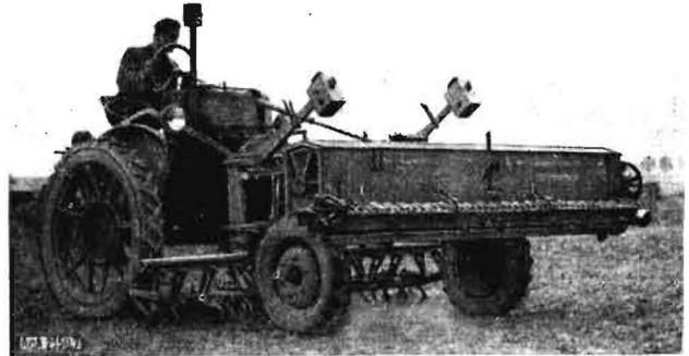
Bild 7. Geräteträger RS 08/15 „Maulwurf“, 15 PS, mit Düngerstreuer und Vielfachgerät
