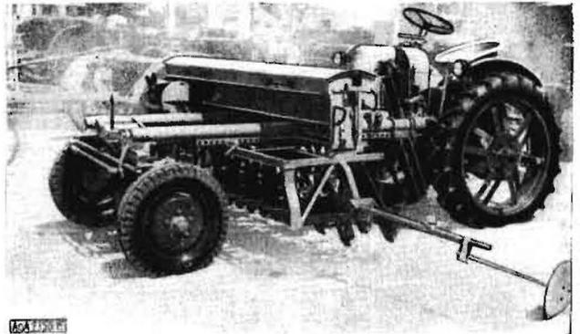
Bild 15. Eicher „Kombi“, 19 PS, mit Drillmaschine
