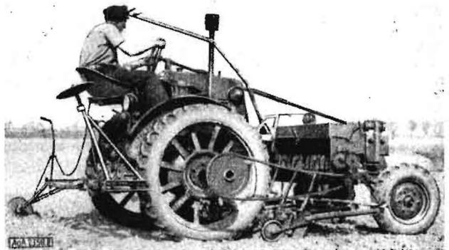
Bild 8. „Maulwurf“ mit Drillmaschine
