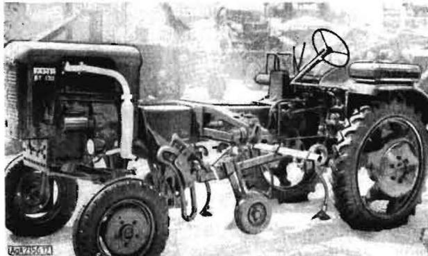
Bild 12. Fahr-„Geräte-Trak“, 17 PS, mit Anbaugrubber
