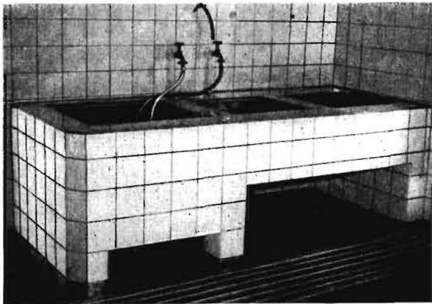
Bild 22. Das gemauerte dreiteilige Einweich-, Reinigungs- und Desinfektionsbecken
