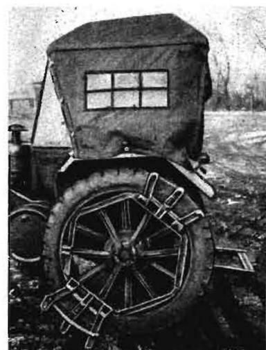
Bild 1. 17 PS LANS-Schlepper mit dem neuen Mehrzweck-Greiferrad im Prinzipversuch (an Stelle der sechs gleichmäßig am Radumfang vorgesehenen Greiferglieder sind nur zwei vorhanden)
