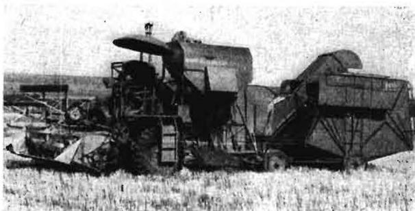
Bild 9. Mähdrescher AC-400 mit Strohsammelwagen
