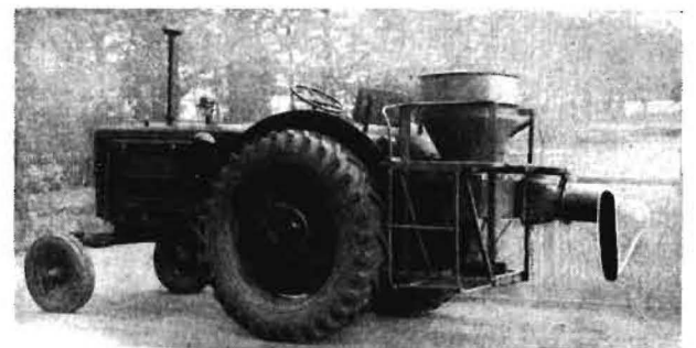
Bild 16. Pneumatisches Schnellstäubegegerät OPS-50 am Schlepper „Belarus“
