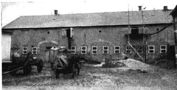
Bild 12. Scheune nach dem Umbau zum Schweinestall
