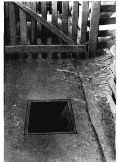
Bild 13. Mistgang mit geöffnetem Abwurfschacht der Schwemmentmistung
