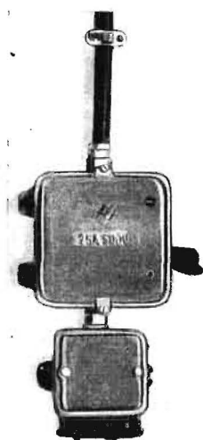
Bild 3. Vorschriftsmäßiger Kraftanschluß für ortsveränderliche Geräte
