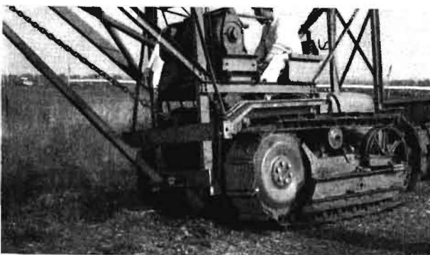
Bild 8. Schürfkübelbagger „Whitlock“. Tragkonstruktion mit Seilwinden und erhöhtem Sitz für Bedienung
