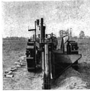
Bild 12. Rückansicht des „Howard“-Drainagebaggers. Die Zuführrinne ist mit Tonrohren besetzt. Der vom Fräsrad ausgehobene Boden wird über eine kurze Rutsche rechts neben dem Graben abgelegt
