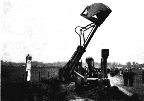
Bild 7. Grabenbagger „Landrainer“ beim Grabenziehen dicht neben einer Umzäunung
