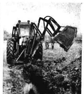
Bild 5. „Dinkum Digger“ bei der Arbeit
