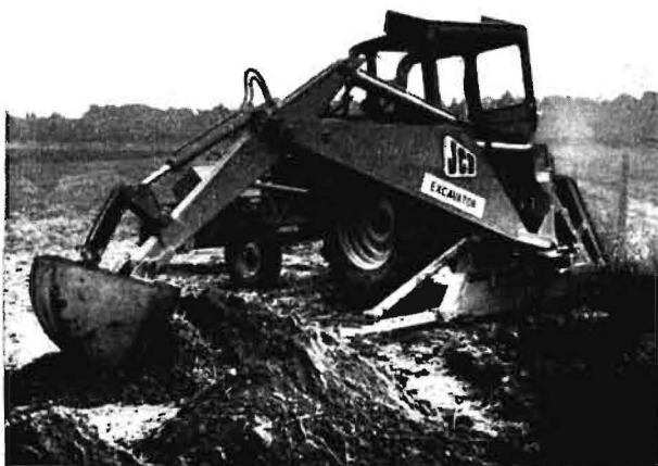
Bild 1. Anbaugrabenbagger ICB mit Grabenschaukel
