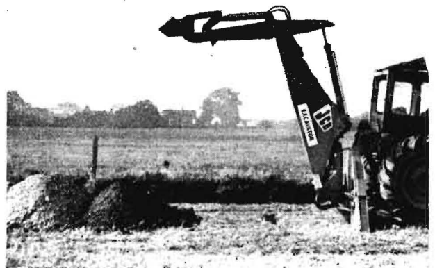
Bild 2. Anbaugrabenbagger ICB mit Grabenkübel bei der Arbeit dicht neben einer Umzäunung
