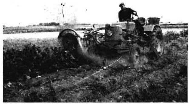
Bild 5. Krautzieher von A. GERLSMA, Franeker, Niederlande, bei der Arbeit
