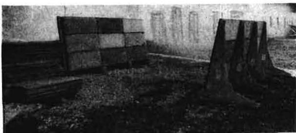
Bild 19. Betonfertigteile für den Bau von Fahrsilos in HABO
