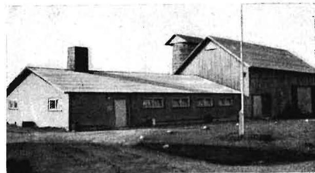
Bild 9. Ansicht des Genossenschaftsstalles UDBY mit Monoschacht für die Entlüftung und erdlastigem Bergeraum
