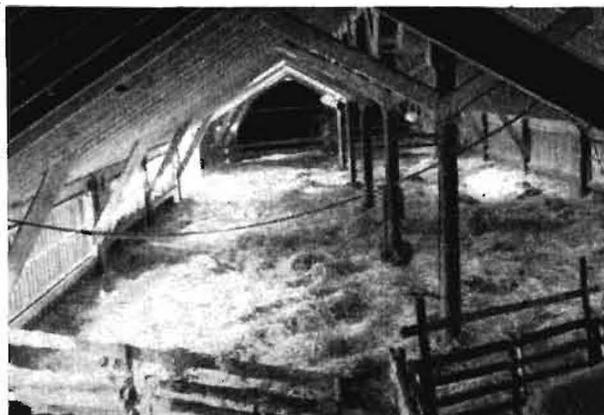
**Bild 4.** Mastenbauweise im Laufstall EBBESKOVE (Dänemark). In diesem Stall betreut eine Arbeitskraft 45 Milchkuhe und 30 Stück Jungvieh
