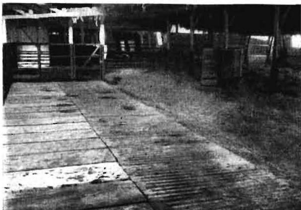
**Bild 3.** Die Lattenroste aus Beton im Laufstall in HABO fördern die Sauberhaltung der Kühe
