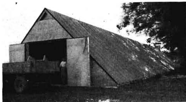
Bild 35. Kartoffellagerhaus HABO. Die Bauform des Gebäudes ist dem Schüttkegel der Kartoffel angepaßt. Das Kartoffelförderband verläuft im First des Lagerhauses
