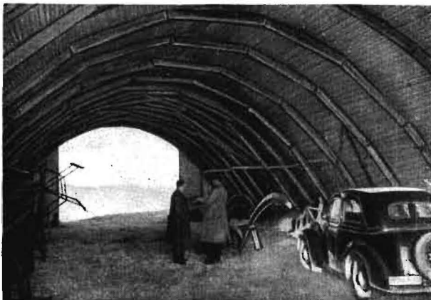
Bild 42. Blick in einen Maschinenschuppen aus Wellaluminium in HABO
