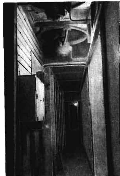
Bild 38. Genossenschaftliches Lagerhaus in Schweden. Entlüftungskanal, in dem die Ventilatoren eingebaut sind. Links unten die Ventilationsöffnungen zum Kartoffelstapel
