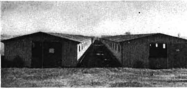
Bild 32. Schweinegroßmästerei in STORA-BERNSTORP. Die Tröge befinden sich an der Außenwand des Stalles und können im Vorverfahren beschickt werden
