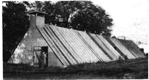
Bild 37. Kartoffellagerhaus HABO. Der Entlüftungskanal mündet in den Abluftschacht, in dem ein Ventilator eingebaut ist
