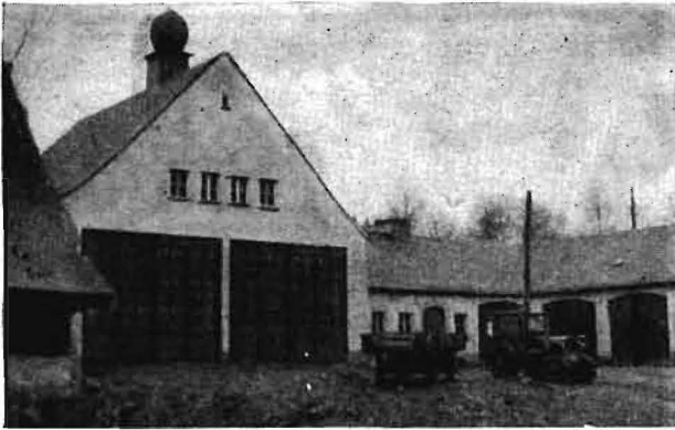
Bild 1. Neu erbauter MTS-Stützpunkt in der LPG Oberwiera, Kreis Glauchau
