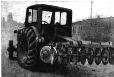
Bild 17. RS 01/40 „Pionier“ mit Dreipunkthydraulik und Anbauscheibenege des VEB BBG in Versuchsausführung
