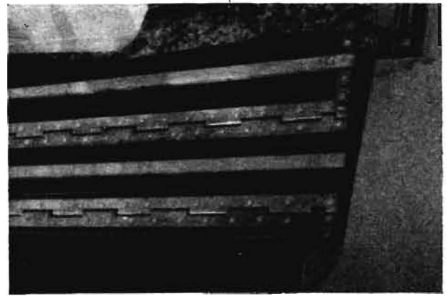
Bild 16. Verschußenden mit Blech verstärkt
