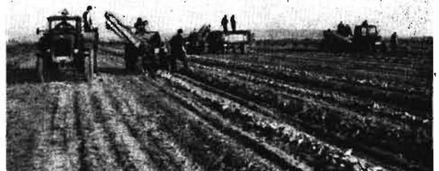
Bild 6. Vollmechanisierte Rüben-ernte mit den drei Maschinen des Systems BBG
