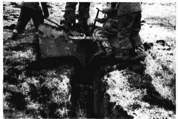
Bild 15. Mitunter sind bis zu sechs Mann an dem Grabenpflug beschäftigt und versuchen, den verstopften und sich aushebenden Pflug durch ihr Körpergewicht in den Graben zurückzudrücken bzw. mit Haken und Spaten die stockende Förderung wieder in Gang zu bringen
