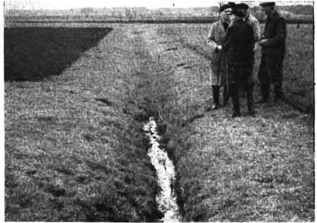
Bild 13. Stark verflachter und verkrauteter Graben, in dem der Pflug führungslos hin- und herpendelt. Das Kraut wird von den starren Vorschneidern oder Scheibensechen nicht zerschnitten und kann demzufolge auch nicht herausgefördert werden
