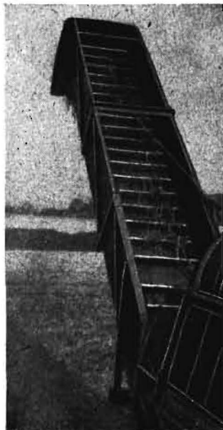
◀ Bild 4. Das unter der Trommel liegende Förderband setzt sich in den seitlichen Auslegern fort. Deutlich sind die Querverstrebungen und die Abdeckung der Auswurföffnung, an der es zu Stockungen kommt, zu erkennen
