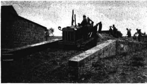
Bild 8. Der Kettenschlepper übernimmt das Festpressen des Futterstockes im Silo so lange...
