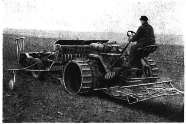
Bild 13. Kombination des Düngerstreuers mit Drillmaschine und Egge am Geräteträger
