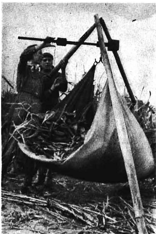
Bild 1. Die Quadratmeterprobe gibt Aufschluß über die benötigte Transportkapazität und den erforderlichen Siloraum
