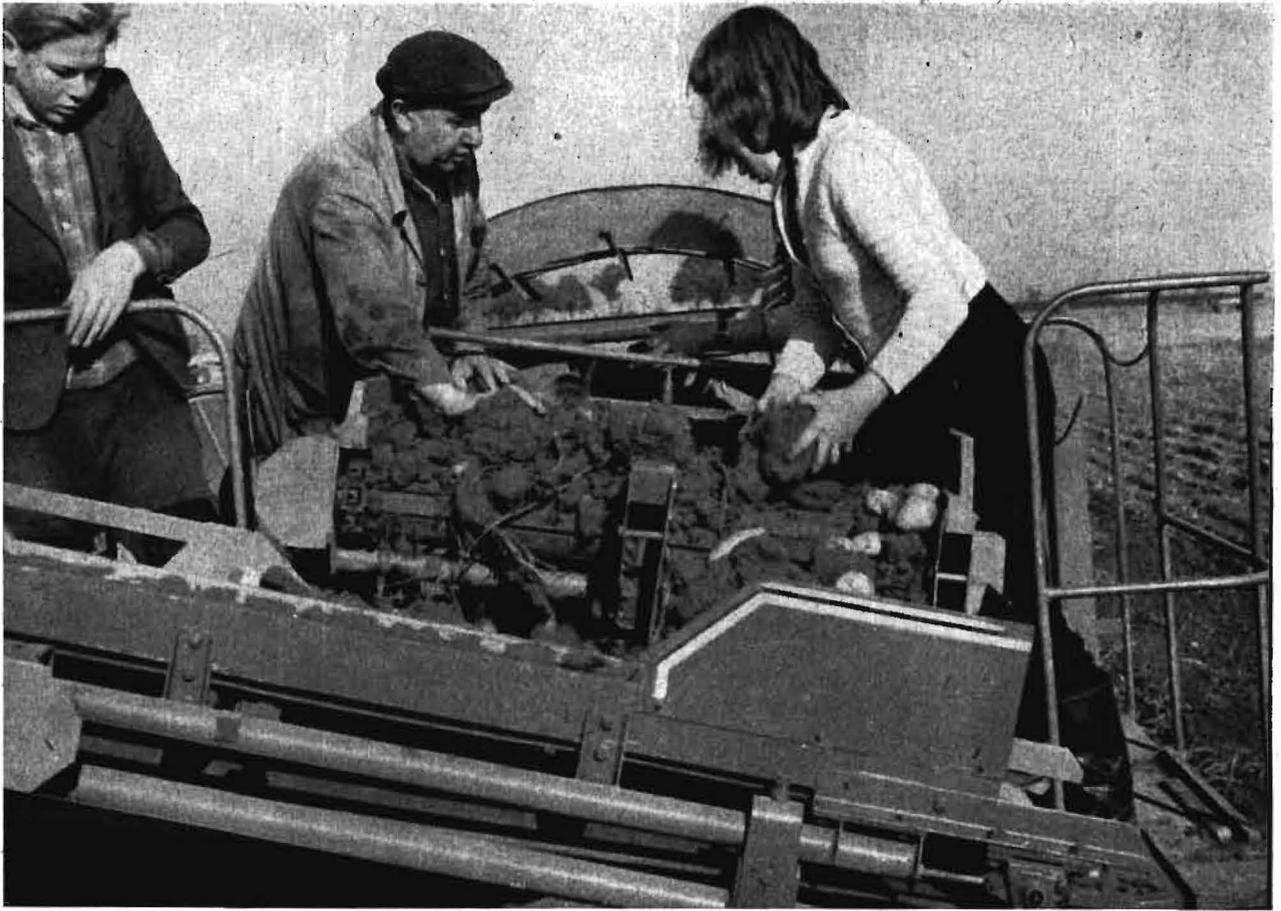
Bild 1. Bei lehmigem Boden gelangen trotz Klutenwalzen viele Kluten auf den Auslesestand der E 372
