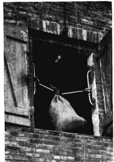
Bild 1. Selbstschließender Luken- und Türschutz in Rohrkonstruktion a Türrahmen oder Wand, b Rohrbügel \frac{3}{4} ", c Abstützbügel, d Muffe 1", oberes bewegliches Teilstück, e Spiralfeder, f Muffe 1", unteres feststehendes Teilstück, g selbstschließendes Schutzrohr
