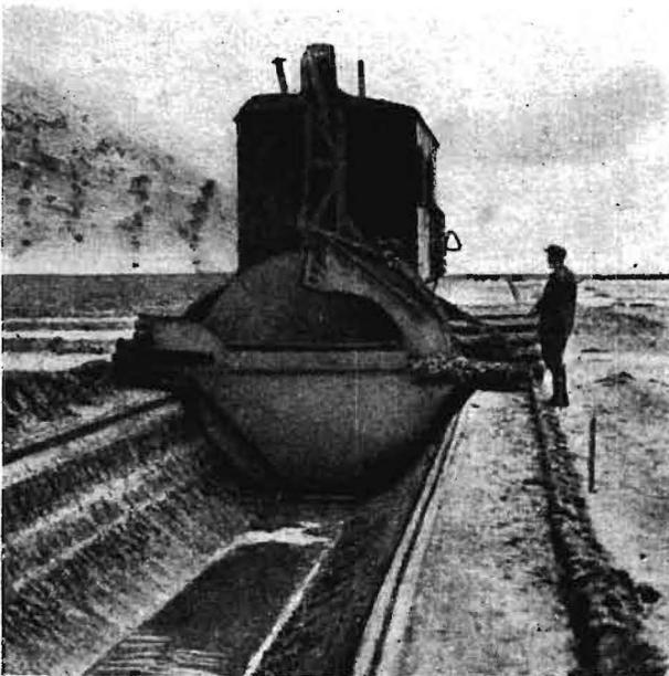
Grabens angeordnet ist (Bild 3), wodurch Grabenherstellung und Aushubverteilung in einem Arbeitsgang erfolgen. Für das Herstellen von Beetgräben unter unseren Verhältnissen sind derartige Maschinen noch nicht erprobt worden, so daß wir mit dem Grabenpflug über den bisher einzigen Gerätetyp verfügen, mit dem diese Arbeit mechanisiert werden kann.
