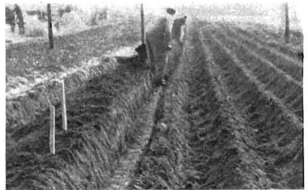
Bild 2. Ausheben der Gräben
