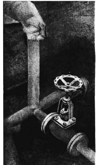
Bild 8. Oberirdisch verlegte Dampfzuleitung (3 1/2" Eisenrohr mit Glaswollmatten isoliert)
