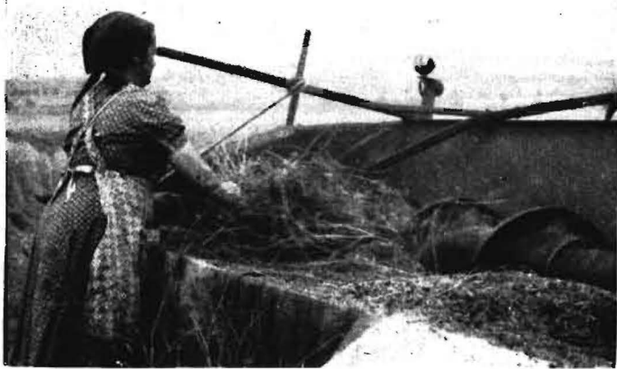
Bild 2. Sauberes Einlegen an einer Seite der Einzugschwelle ist erforderlich
