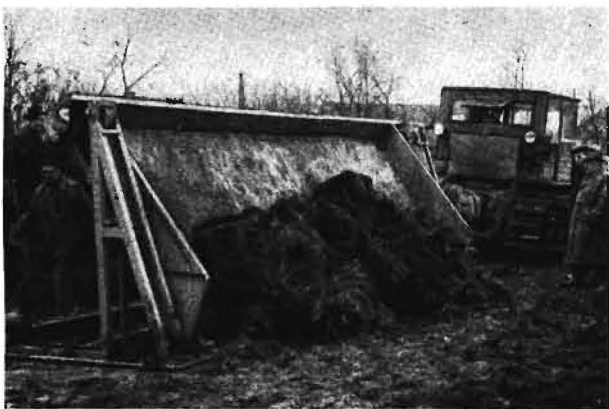
Bild 3. Gleitförderer für den Transport der ausgehobenen Erdmassen mit mechanischer Hubvorrichtung
