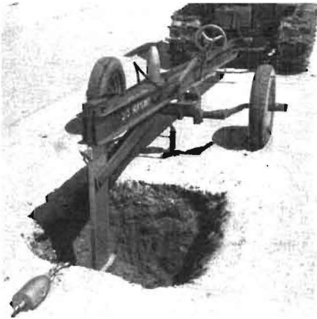
Bild 6. Maulwurfsdränpflug der MTS Rokycany
