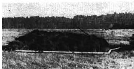
Bild 4. Gleitförderer, mit 5 m 3 Erdmassen beladen
