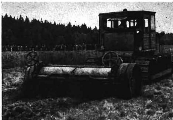
Bild 2. Bodenfräse FB-1,9 bei der Arbeit
