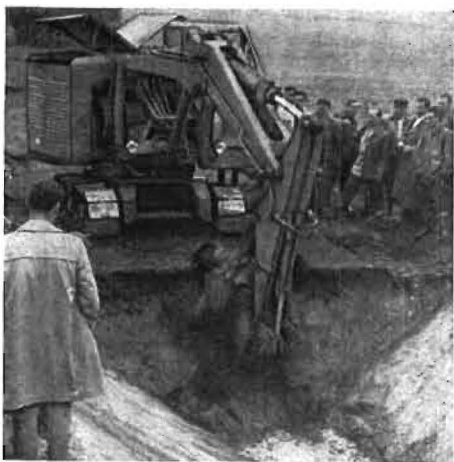
Bild 3. Universalbagger UB 20 im Einsatz
