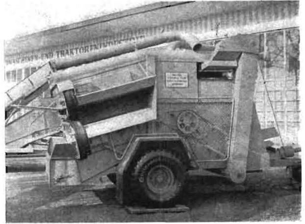
**Bild 4.** Faserpflanzen-Entsamungsmaschine K 155 „Faserdrusch“, Neuentwicklung vom VEB Fortschritt Neustadt/Sa
