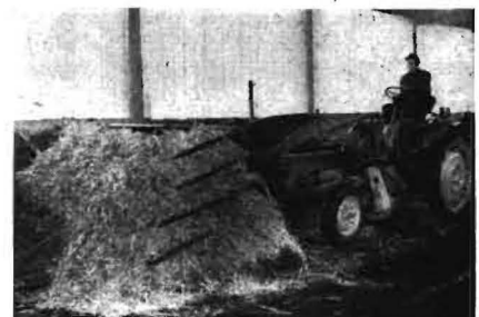
Bild 8. Einstreuen von Häckselstroh im Rinderflachlaufstall mit dem Häckselbehälter
