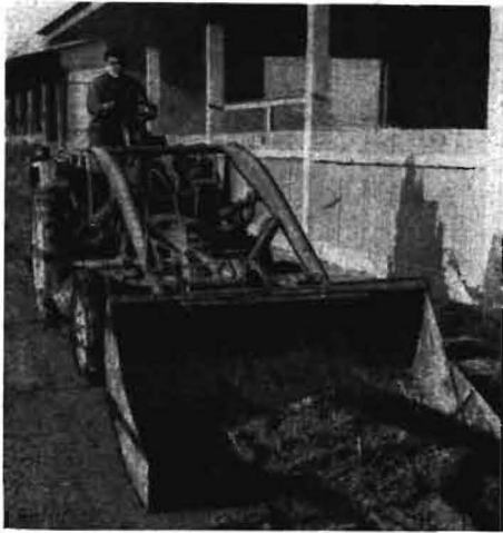
Bild 6. Räumen der Auslauflächen
