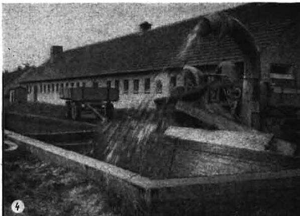
Bild 4. Füllen eines Tiefsilos mit einem Silo-Gebläse-Häcksler F 53
