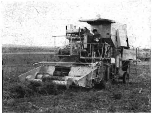
Bild 2. Mähdrescher E 175 mit Schwadaufnahmetrommel, im Einsatz beim Schwaddrusch von Rübensamen
