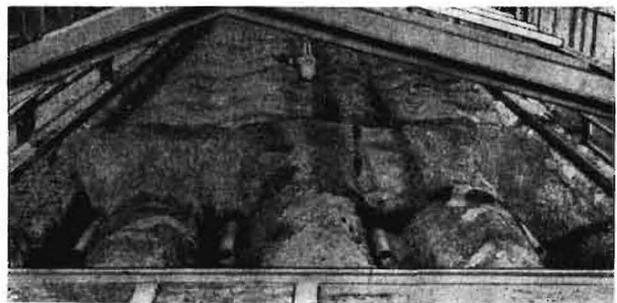
Bild 5. Teilweise freigelegtes Dränbodenheizungssystem im MF 56
