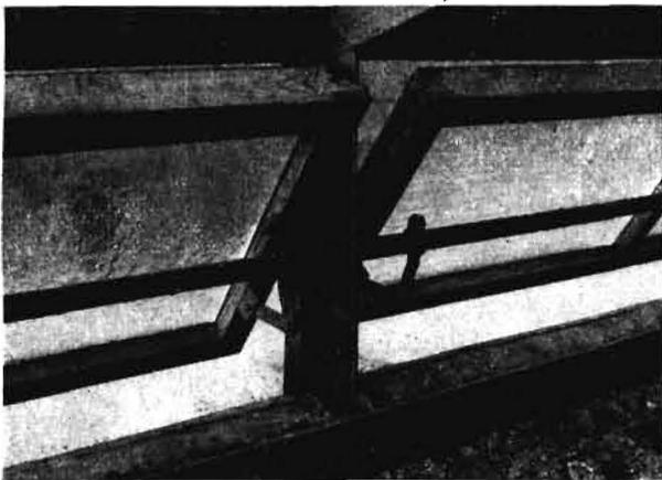
Bild 3. Konstruktionselemente (Welle und Knagge) zur Bedienung der Ganzstehwandlüftung
