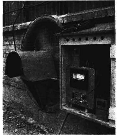
Bild 4. Hebelwaage zur Feuchtigkeits- bestimmung
