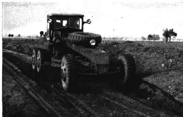
Bild 4. Straßenhobel beim Profilieren
