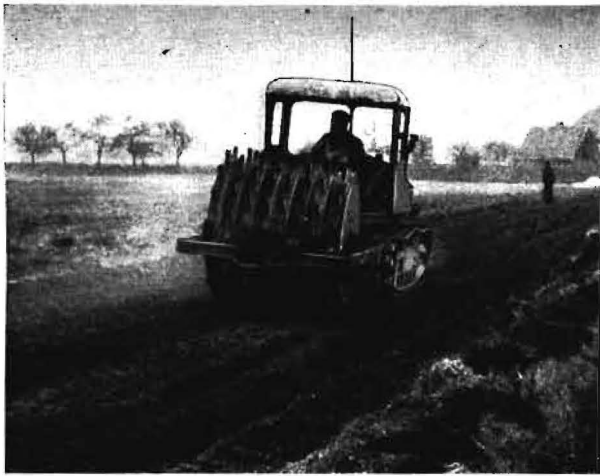
Bild 8. Schafffußwalze bei der Verdichtung von Schluffboden
