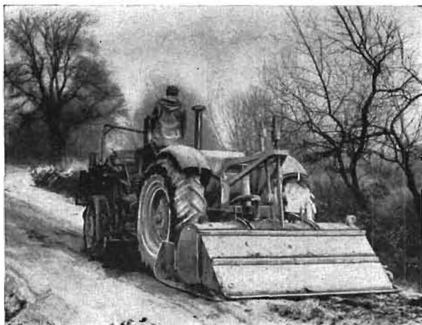
Bild 7. Mehrgangmischer beim Einmischen von Branntkalk
