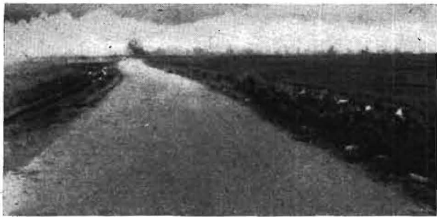
Bild 12. Bodenstabilisierung als Versuchsstrecke in der altmärkischen Wische
