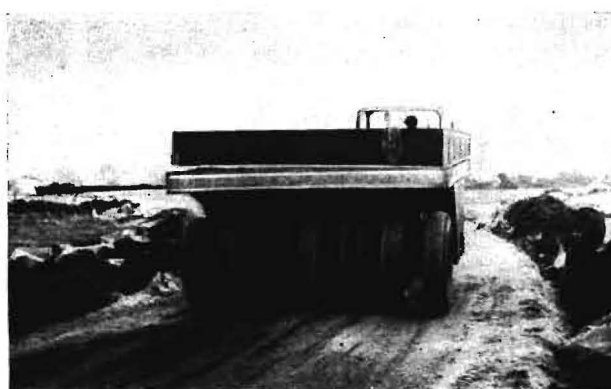
Bild 9. Gummiradwalze auf Kalkstabilisierung
