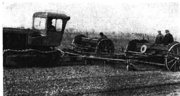
Bild 2. Kopplung von drei Drillmaschinen mit dem Kopplungsbalke Z 102
