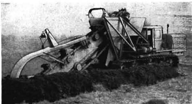
Bild 7. Eimerketten-Grabenbagger ETN-142 bei der Dränung
