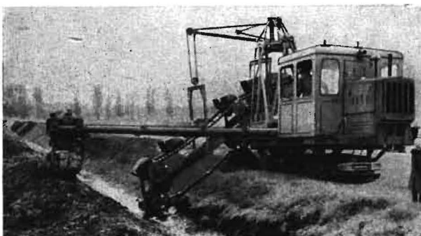
Bild 11. Eimerkettenbagger EM-502 bei der Grabeninstandsetzung
