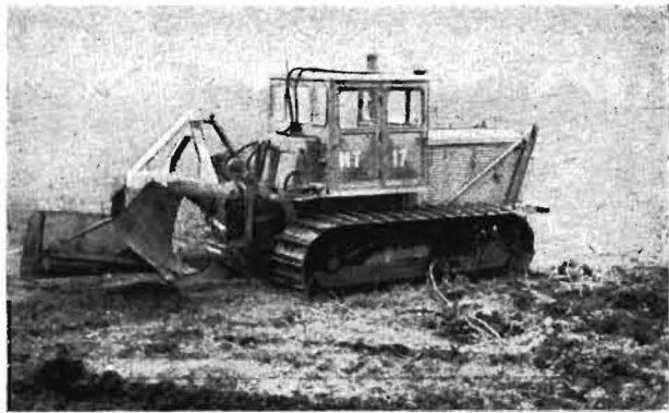
Bild 5. Traktor S-80 mit Moorpflug
