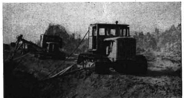
Bild 13. Maschinensystem für die Instandsetzung von Gräben, bestehend aus einem Böschungshobel und dem Grabenreiniger KOM-80
