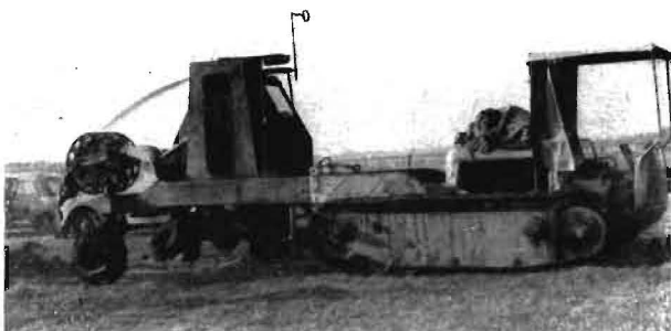
Bild 1. Dränstrangverlegemaschine, aufgesetzt auf den Meliorationsschlepper KT 81
