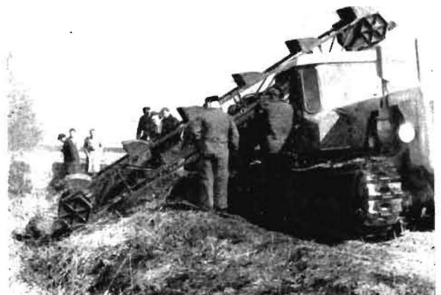
Bild 1. Holzendorfer Grabenbagger bei der Generalreparatur eines Binnenentwässerungsgrabens
