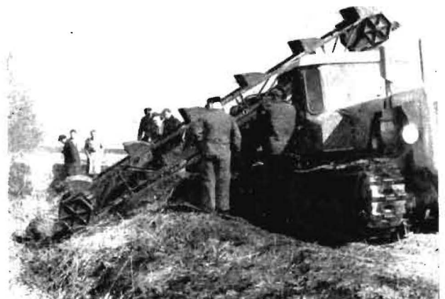
Bild 1. Holzendorfer Grabenbagger bei der Generalreparatur eines Binnenentwässerungsgrabens
