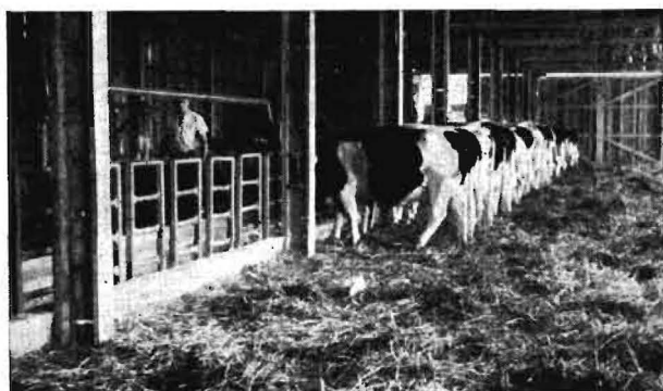
Bild 1. Die mittlere Stützenreihe, auf dem Freßplatz stehend, erschwert ein sauberes, risikoloses Entlangspuren an der Krippenanlage
