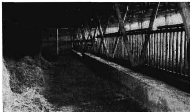
Bild 2. Freistehendes Freßgitter in einem Offenstall der LPG Berlestedt vom Bergeraum her gesehen. Die Krippenschale kann nach wie vor gut gereinigt werden. Ein kontinuierlich arbeitendes Beschickungsgerät (z. B. Futterverteilungswagen) kann eingesetzt werden, ebenso der RS 09 mit Kehr- und Ladeschaufel
