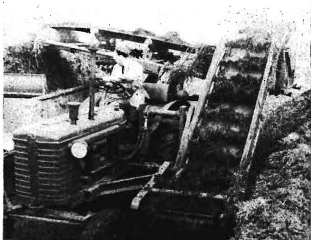
Bild 2. Lockern des Stalldüngs am Düngerschober durch den Fräskopf
