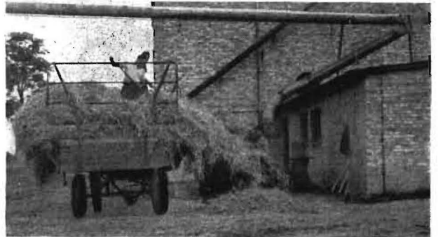
Bild 6. Entladen von langem Mähdruschstroh in Gebläsehäcksler GS 380, der in die Strohtransportleitung zwischen Stall 2 und dem Kartoffellagerhaus einbläst
