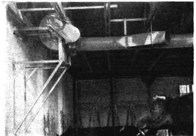
Bild 5a. Zwischengebläse im Stall b (Typ ME 30) in der Häckseltransport- und Abzweigkasten für Leitung nach Stall e. Das Gebläse bläst nach 180° Schwenkung des Gehäuses nach Stall a
