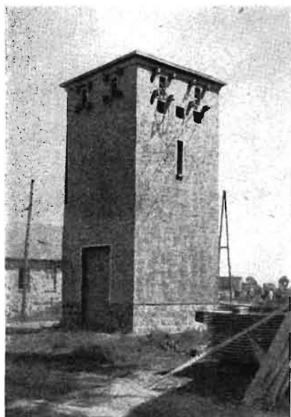
Bild 1 Transformatorstation des Wirtschaftshofes
