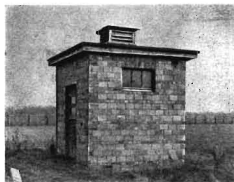
Bild 2 Gasreglerstation der LPG Brehna
